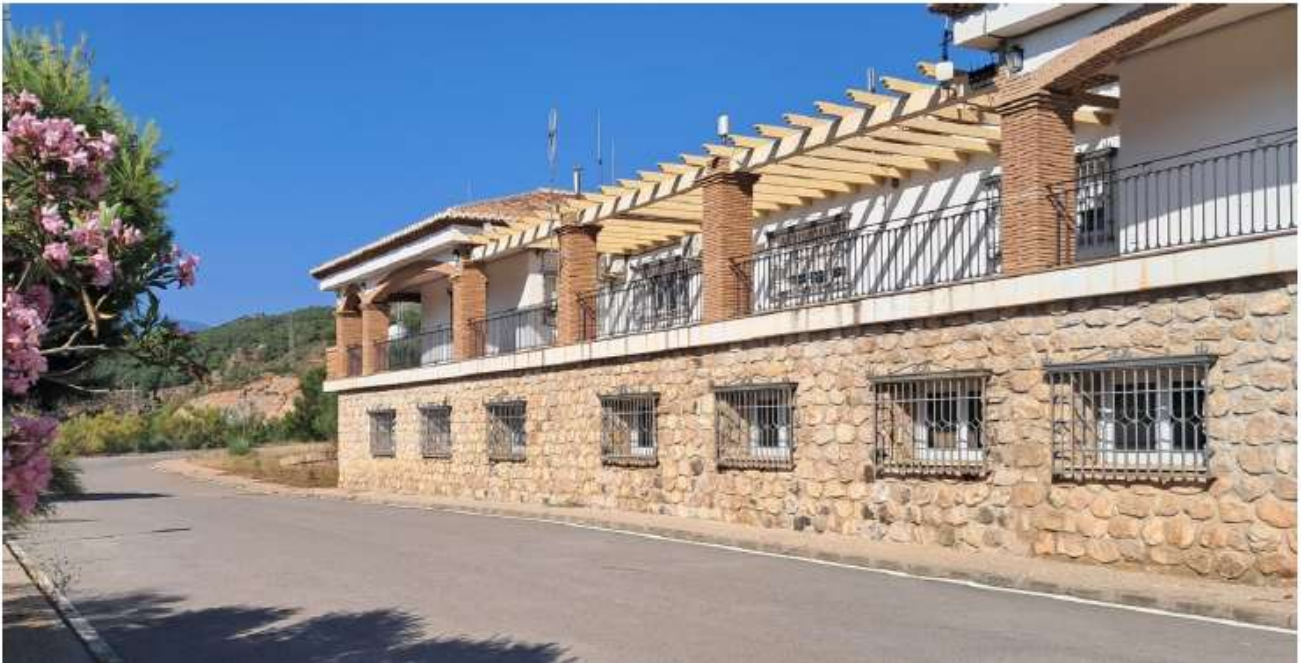
Figura 5.2. Fachada del recinto de la Zona
