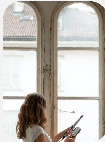
Rehabilitación de ventanas y carpinterías
