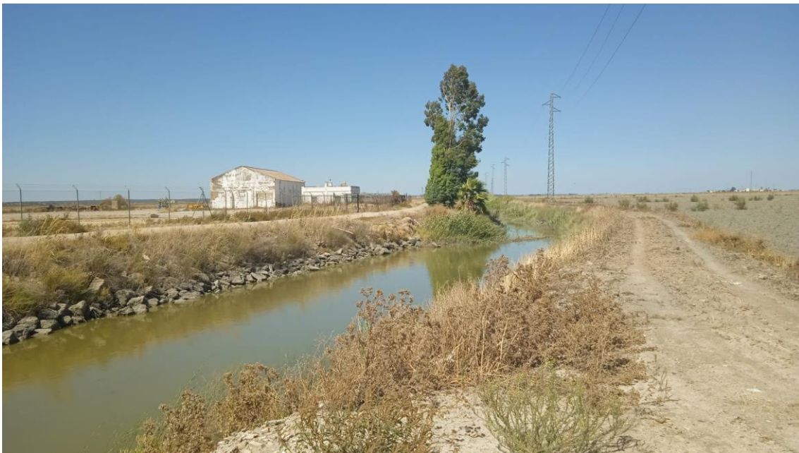
Vista de la UP-3 Vegetación de Riberas, en el canal colector "Los Morrones" que presenta escurrimiento superficial.
