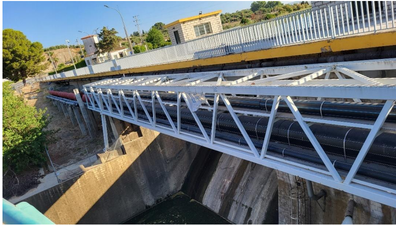
Fotografía 1. Detalle del cruce del Río Guadalete en la presa del Embalse de Arcos.
