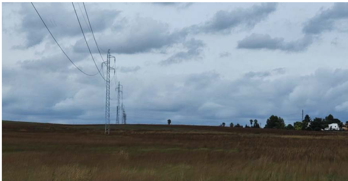
Fotografía 18. Línea Aérea de Alta Tensión "Don Rodrigo Aljarafe" 220 kV próxima a la Planta Solar.
