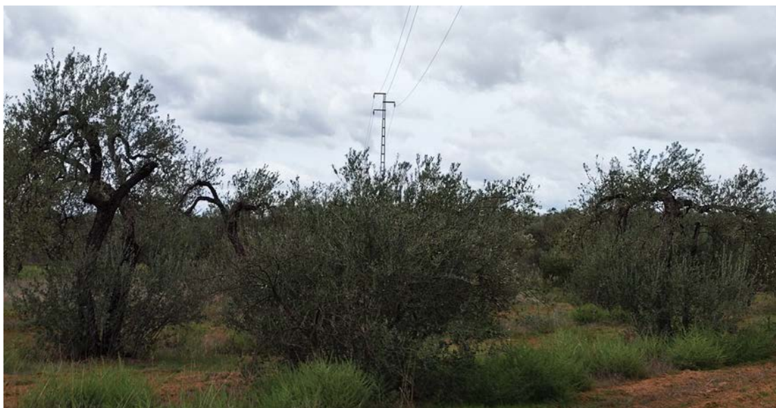
Fotografía 17. Cruce de la Línea Soterrada con Tendido de baja tensión "Aljarafe - Laminill" 66 kV.
