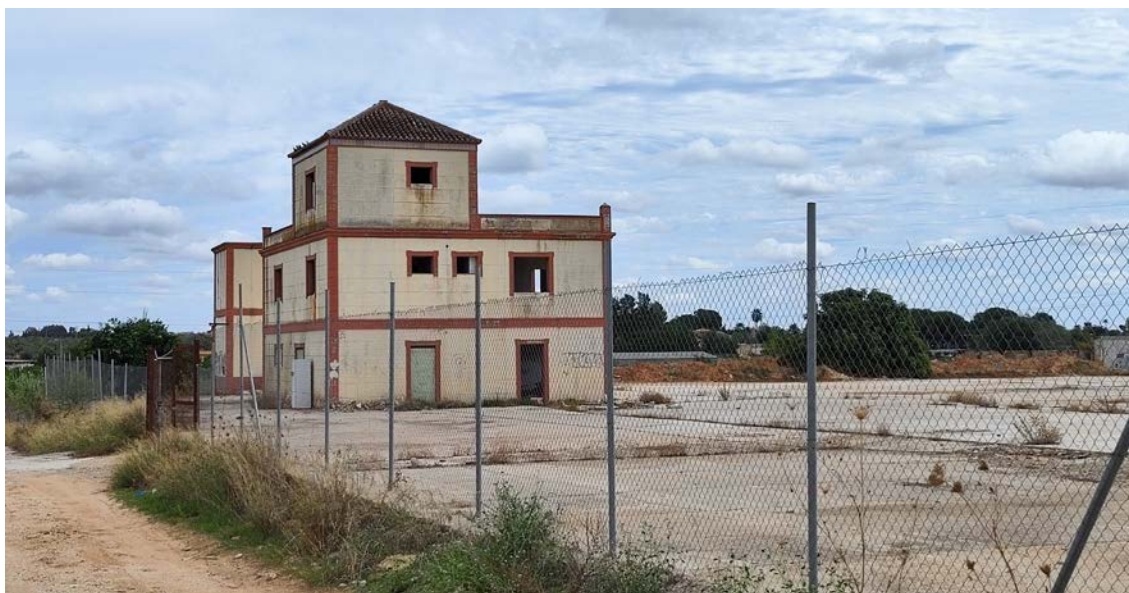
Fotografía 19. Oficinas abandonadas de las obras de la SE40 en las proximidades de la Planta Solar.
