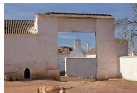
Portón de acceso al patio y perfil de la espadaña de la capilla.
