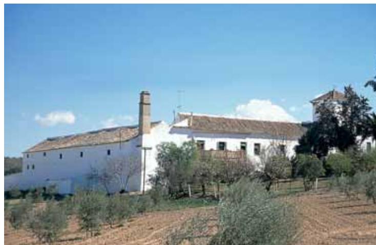
Vista de conjunto, con la chimenea de sección cuadrada de la almazara.
