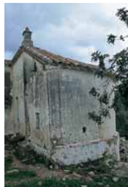
Esquina de la zona de cocina de los trabajadores.
