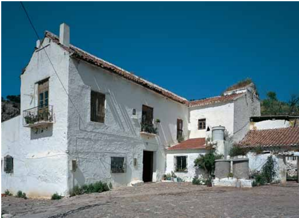
Fachada de la vivienda de los propietarios.
