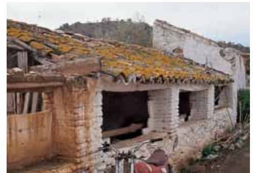
Construcción dedicada a corrales.
