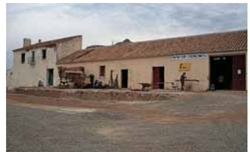
Frente con las naves de vivienda.
