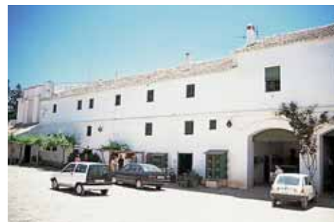
Patio y nave lateral con viviendas, dependencias de servicio y graneros.
