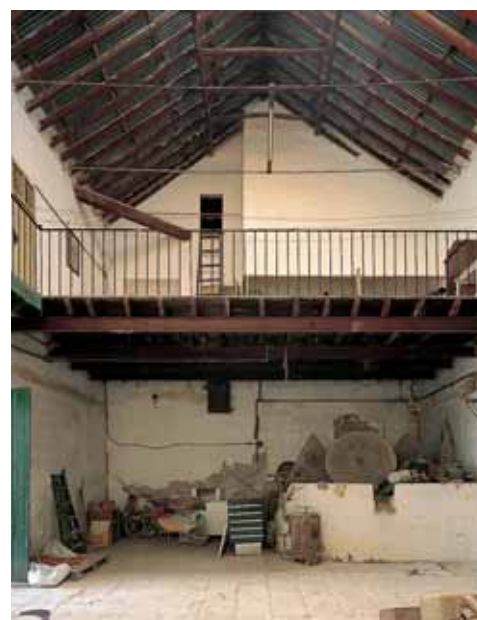
Balconada sobre la nave de la almazara. A la izquierda, granero en el que destaca la estructura de cubiertas.
