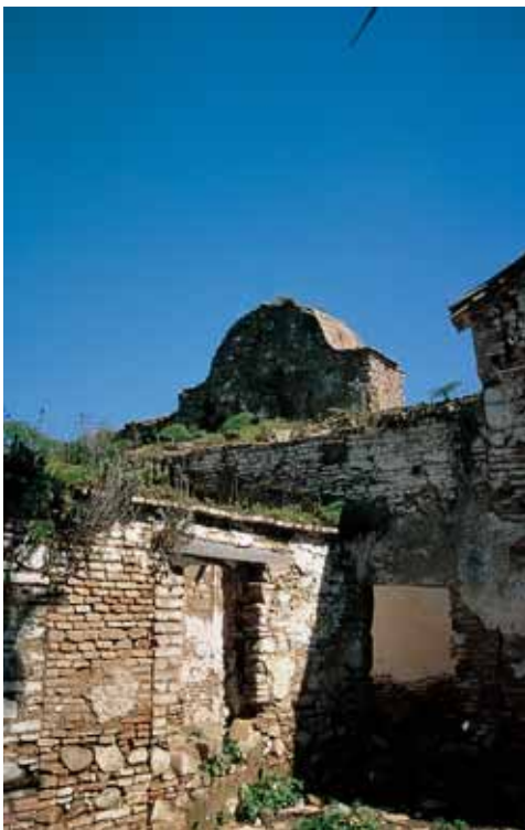
Perfil exterior de la torre de contrapeso del lagar de viga.
