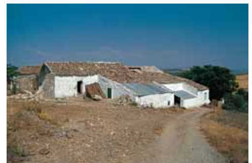
Faldones de cubierta desde la parte trasera.
