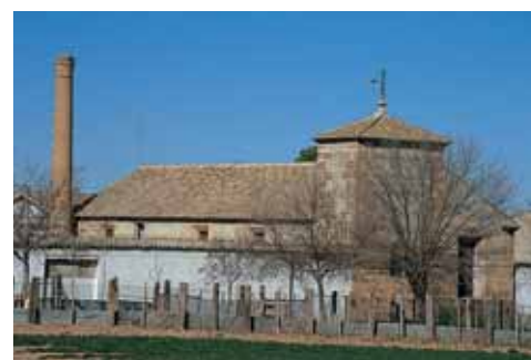
Nave del molino de aceite con torre de contrapeso y chimenea cilíndrica.
