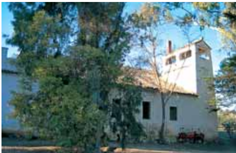
Fachada lateral con la torre de contrapeso.
