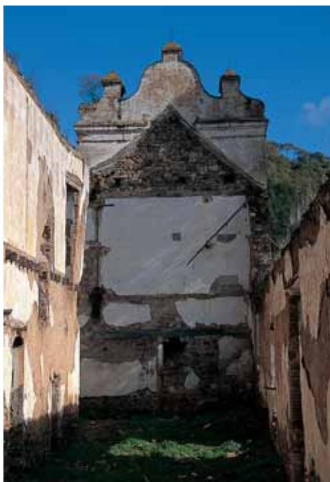
Interior de la nave de la prensa hacia el muro de contrapeso.
