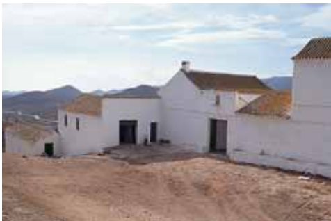
Fachada exterior y portón de entrada.
