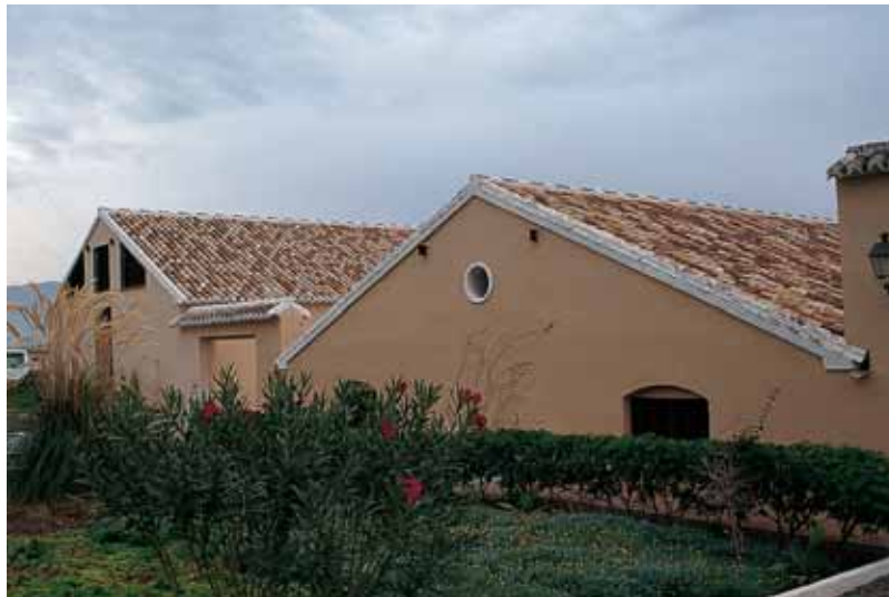
Perfil exterior de las dos naves dedicadas en origen a tinajo.
