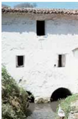
Fachada con los ojos de las bóvedas de desagüe.
