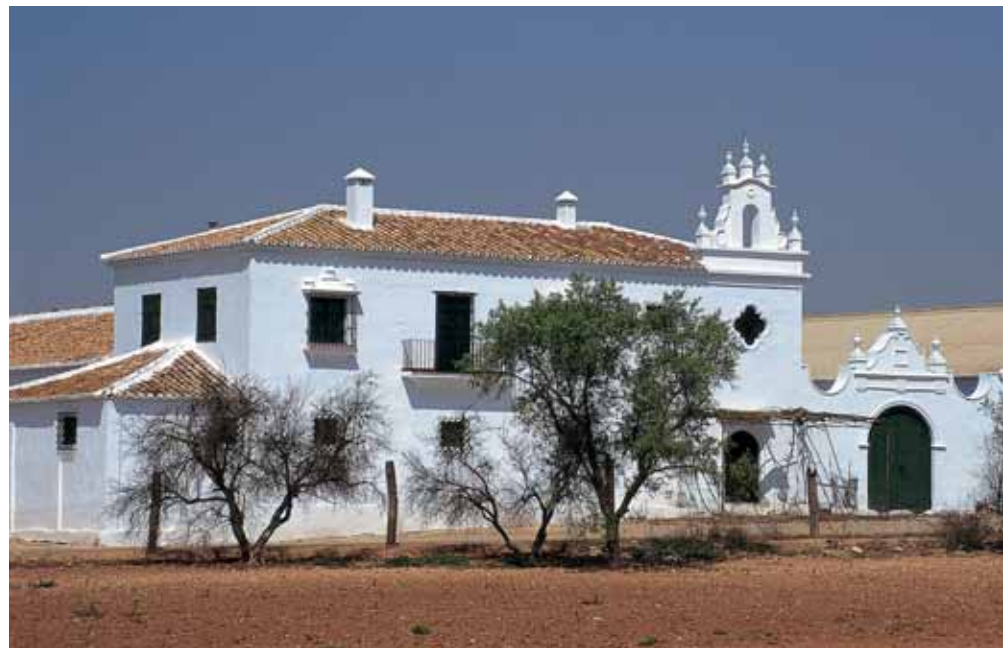
Fachada principal con el señorío y la espadaña de la capilla en primer plano.
