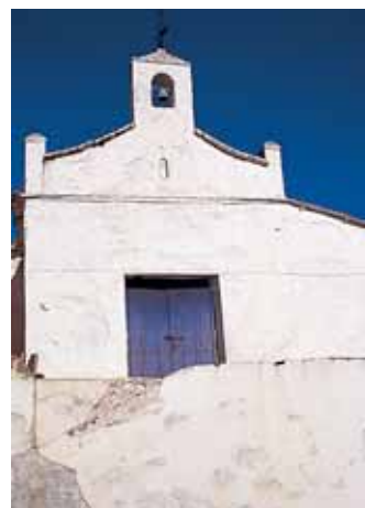
A la izquierda, fachada principal de la zona de vivienda y del molino.
