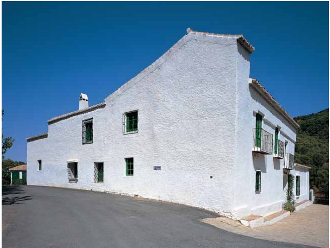
Fachada con el perfil del muro de contrapeso.
