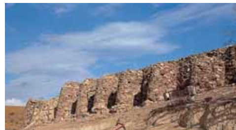
Contrafuertes del muro de contención de la era.
