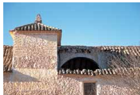
Torre de contrapeso.
