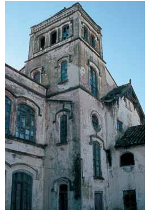
Torre mirador desde el patio interior.
