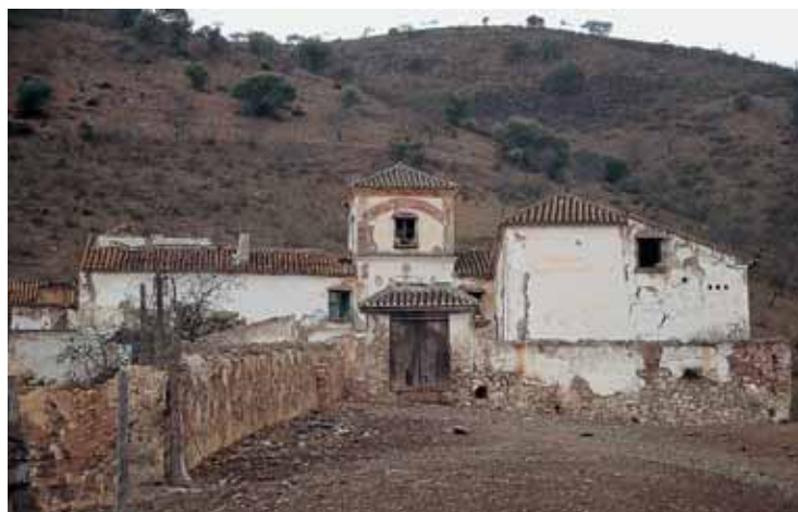
Fachada principal desde el carril de acceso.
