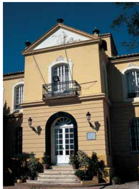
Detalle de la fachada principal del señorío.
