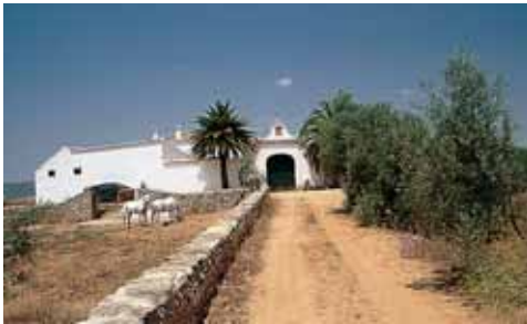
Carril de acceso, a eje con el portón de entrada.
