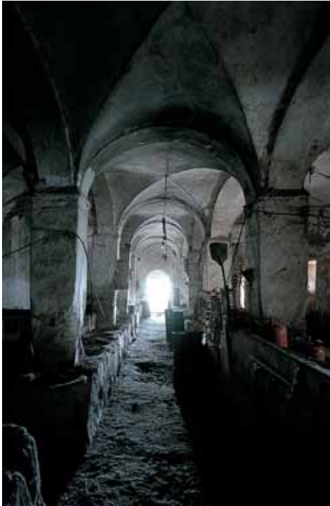
Interior de la nave del tinajo, con pasillo central entre las pesebreras bajo bóvedas de aristas sobre pilares.
