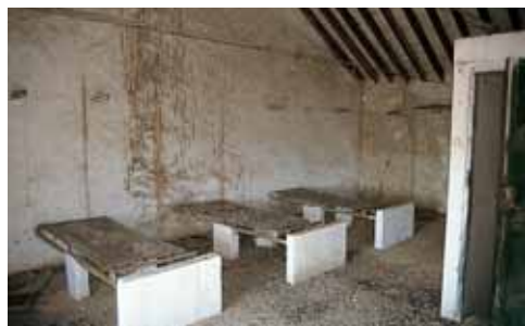
Dormitorio de trabajadores.
