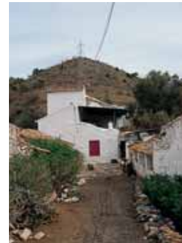
Vista desde el patio hacia la zona de vivienda y nave del lagar, con el perfil del muro de contrapeso.
