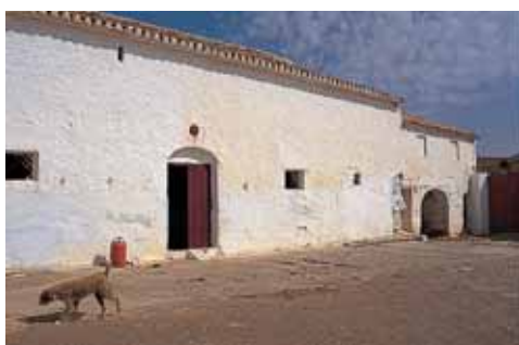
Fachada de la zona del molino desde el patio.
