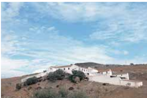
Vista general desde la carretera de acceso.
