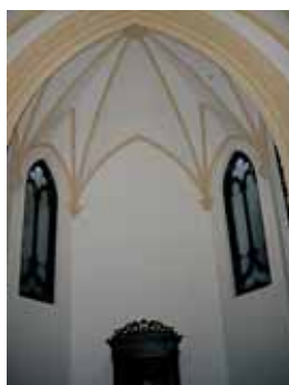
A la izquierda, fachada exterior de la capilla.
