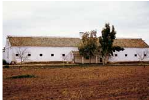
Fachada trasera y fachada principal.
