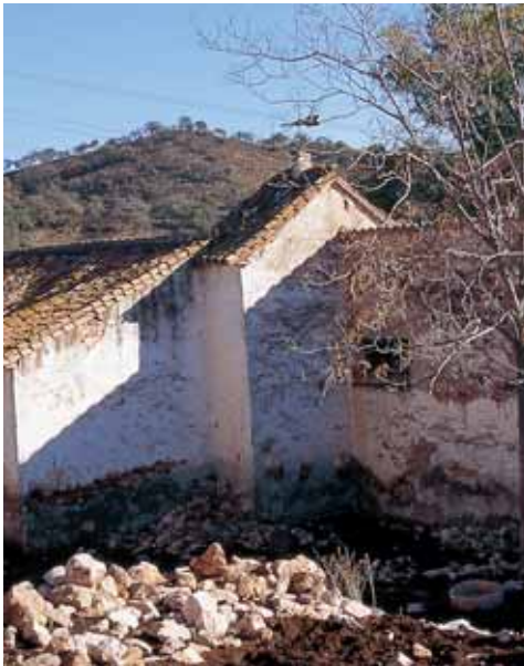
Lateral en el que destaca el muro de contrapeso del lagar.
