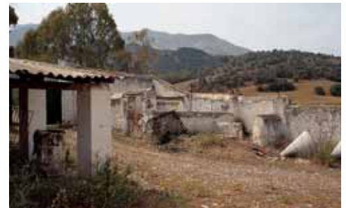
Patio de la zona de vivienda con el muro de cierre.
