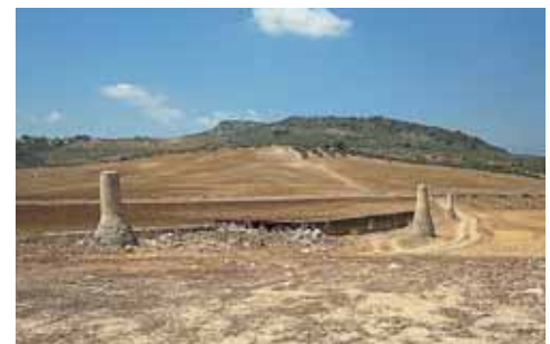
Sifones de la conducción de agua que alimenta la alberca.
