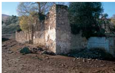
Muros de la primitiva capilla.
