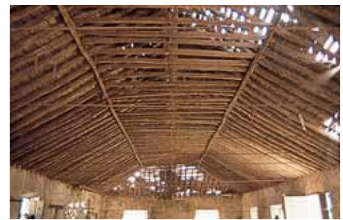
Interior del tinajo, con el sistema primitivo de cubrición con vigas de madera ensambladas en forma de artesa.
