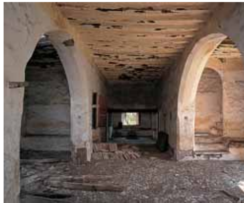
A la izquierda, estado actual de la nave de caballerizas.
