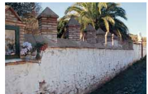
Muro exterior almenado del núcleo primitivo.
