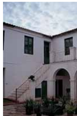
A la izquierda, fachada principal con detalle del porche.
