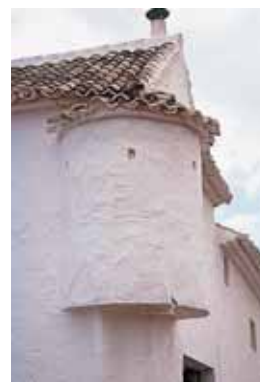
Garita en esquina de planta circular.
