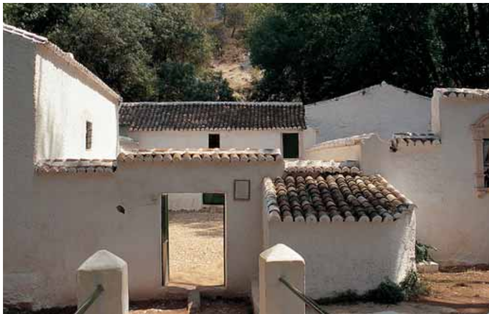
Puerta de entrada al cortijo desde el puente de acceso.
