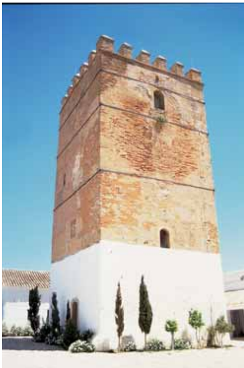
La torre de Ortegícar, exenta en el patio principal del cortijo.
