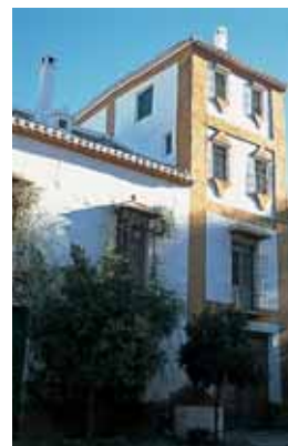
Fachada exterior de la torre mirador.
