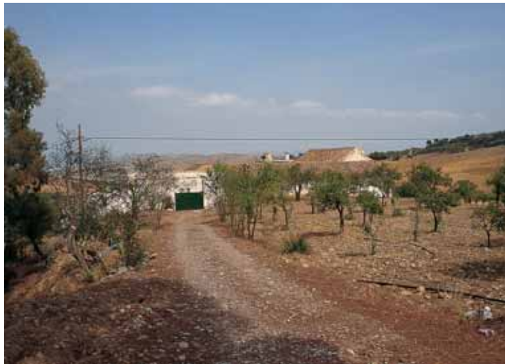
Vista del conjunto desde el carril de acceso.
