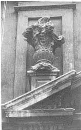
FIG. 4 Detalle de los jarrones que flanquean el balcón central de la fachada de la Casa de la Moneda de Sevilla (1763)
