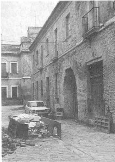
FIG. 15 Vista general del frente de fachada de la calle Matienzo en el sector de la Fundación.
