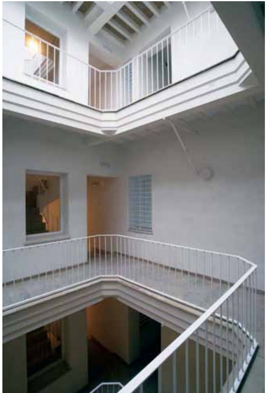
Rehabilitación de edificios de viviendas en calle Santo Domingo 35-37 con Mirador, 13. Cádiz
