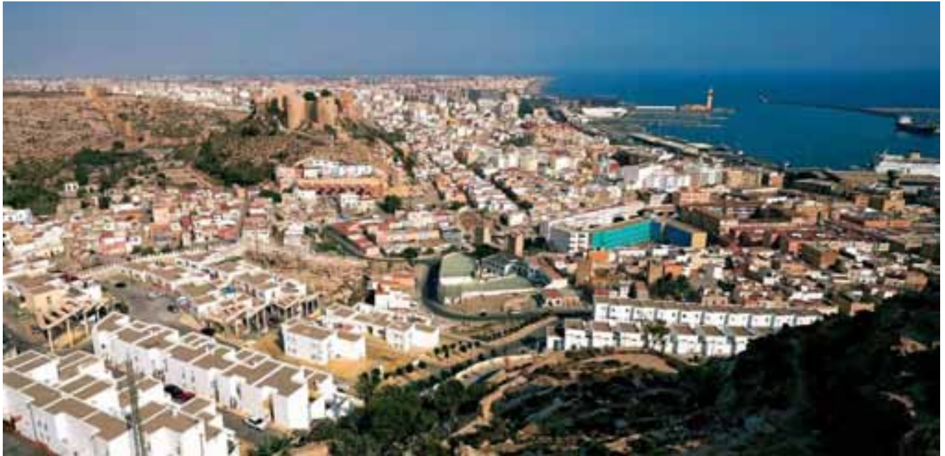
Vista aérea del Área de Rehabilitación de La Chanca en Almería. En primer término se observan las actuaciones realizadas por la Junta de Andalucía Fotógrafo: José Morón
