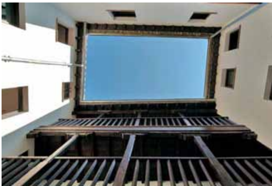
Rehabilitación de edificio de viviendas en calle Carnero nº 4. Granada Arquitecto: Enrique Larive López
