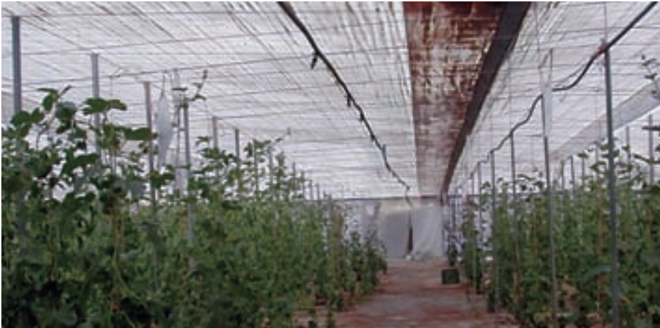
Fig. 63.- Pulverizadores de agua en el techo de un invernadero
