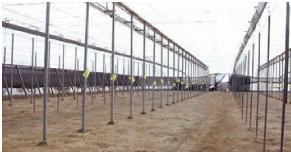
Fig. 79.- Invernadero limpio tras la recolección preparado para plantar. Se observan trampas cromotrópicas amarillas para detección de mosca blanca
