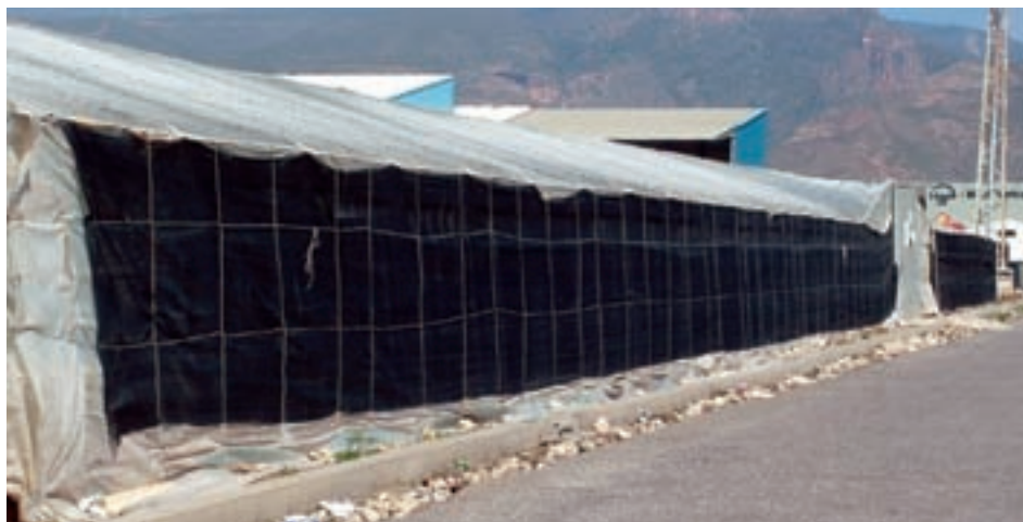
Fig. 62.- Ventilación lateral en un invernadero de plástico
