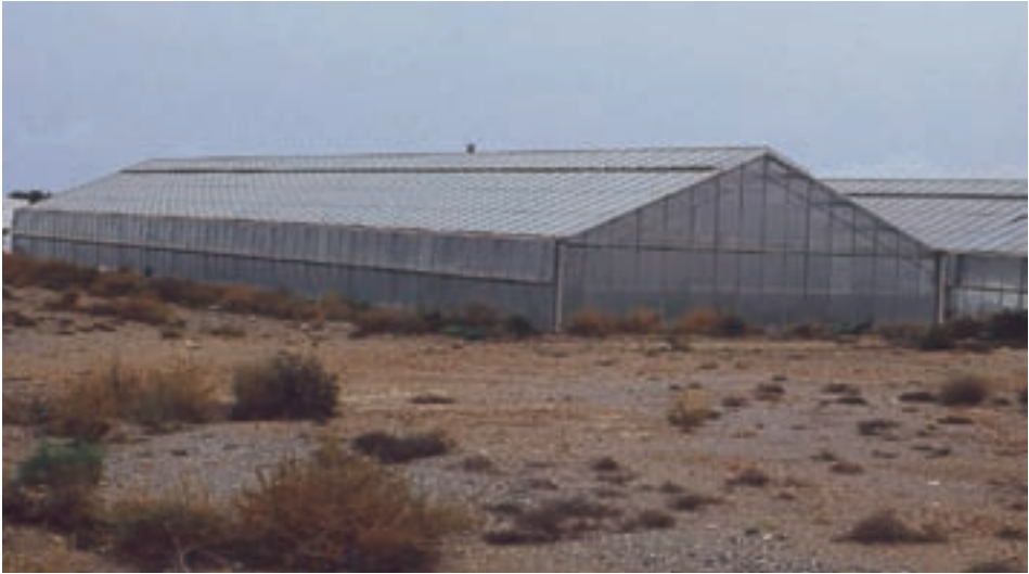
Fig. 55.- Invernadero con cubierta de cristal
