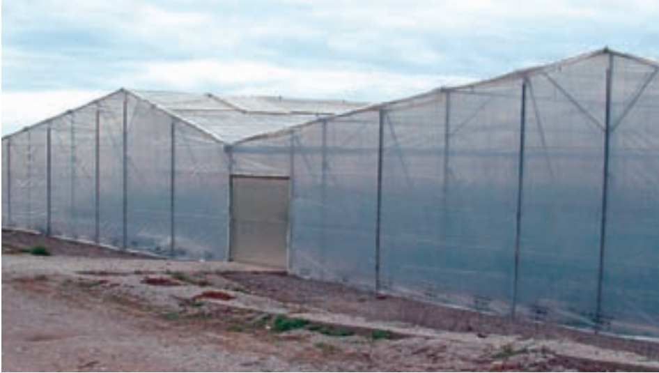
Fig. 58.- Invernaderos de plástico de estructura asimétrica
