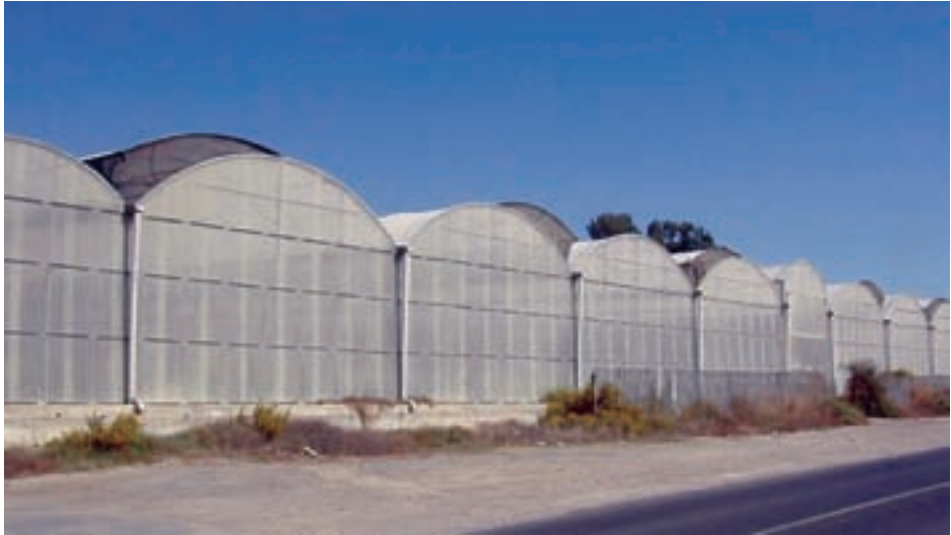
Fig. 57.- Batería de invernaderos tipo túnel con ventilación cenital
