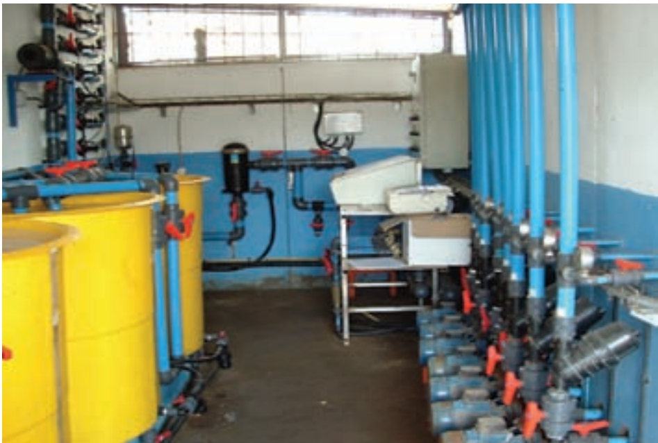
Fig. 67.- Vista general de un sistema informatizado de riego localizado
