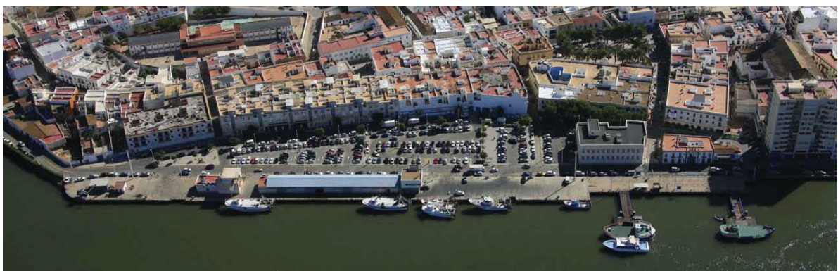
Fig. 31. Muelle pesquero de Ayamonte, con la lonja en el centro y la fábrica de hielo a la izquierda.
