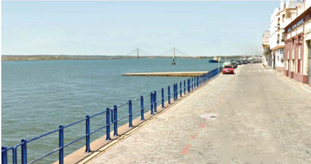
Fig. 15. Calle Muelle de Portugal antes de las actuaciones de integración urbana (2015)
