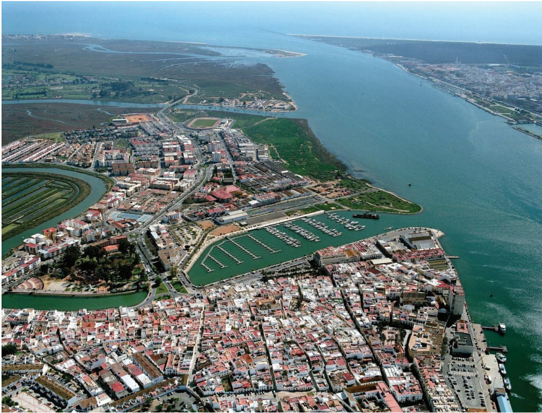
Fig. 14. Dársena recreativa tras la ampliación de capacidad (2006)
