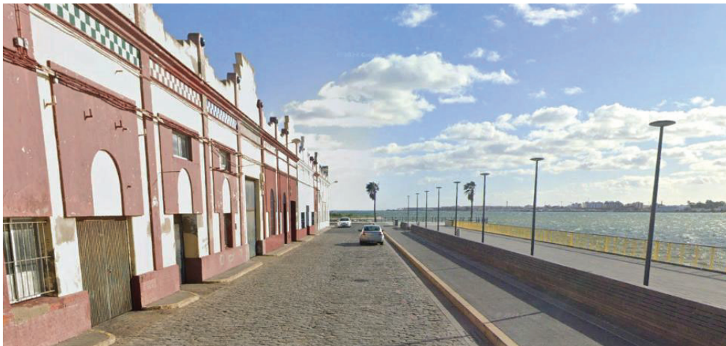
Fig. 40. Urbanización de la ribera del Guadiana
