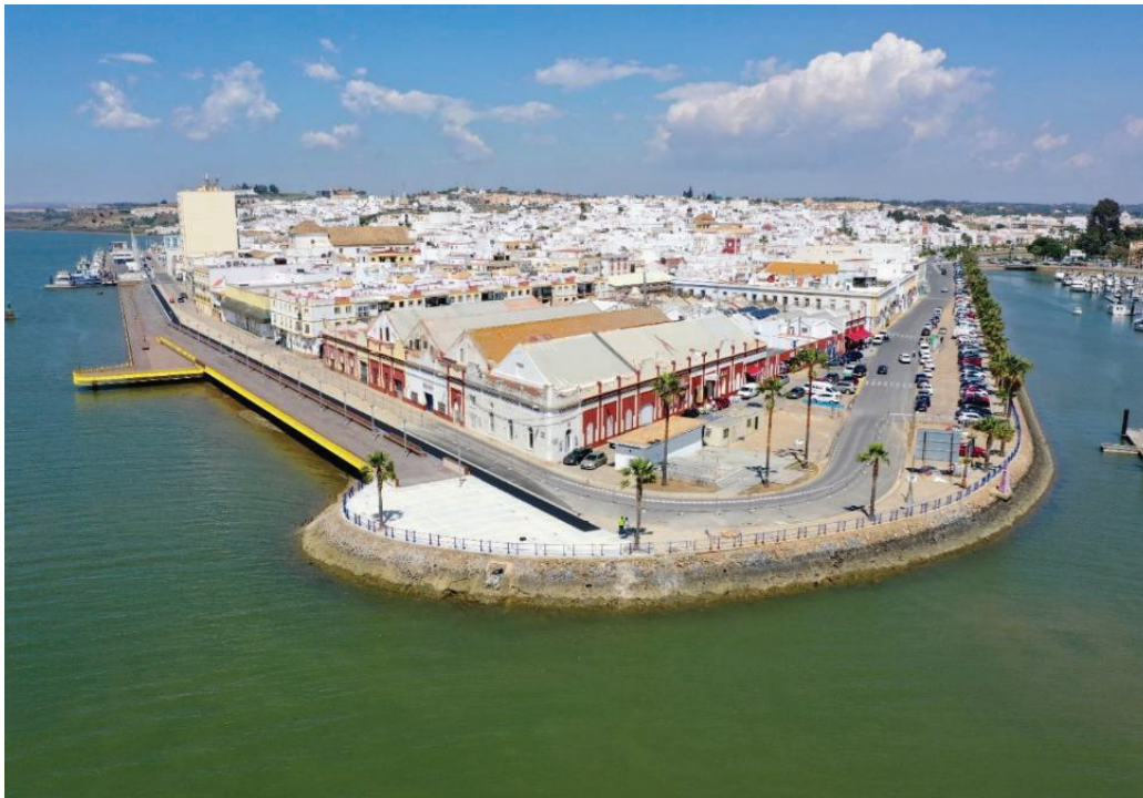
Fig. 29. Frente portuario de la ribera del Guadiana y bocana de acceso a la dársena interior.
