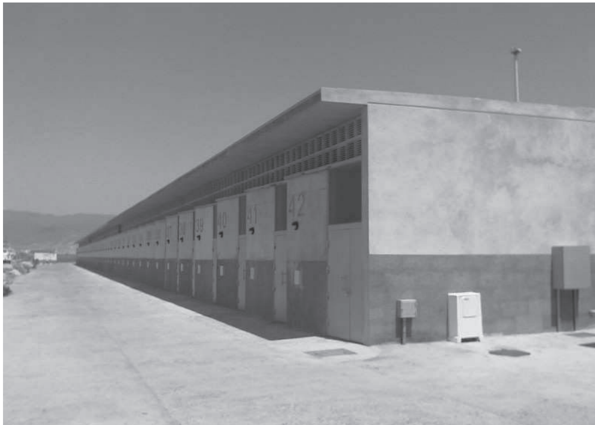
Nuevos cuartos de armadores
